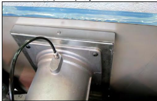
Вид нижней части фильтра после установки на котел
