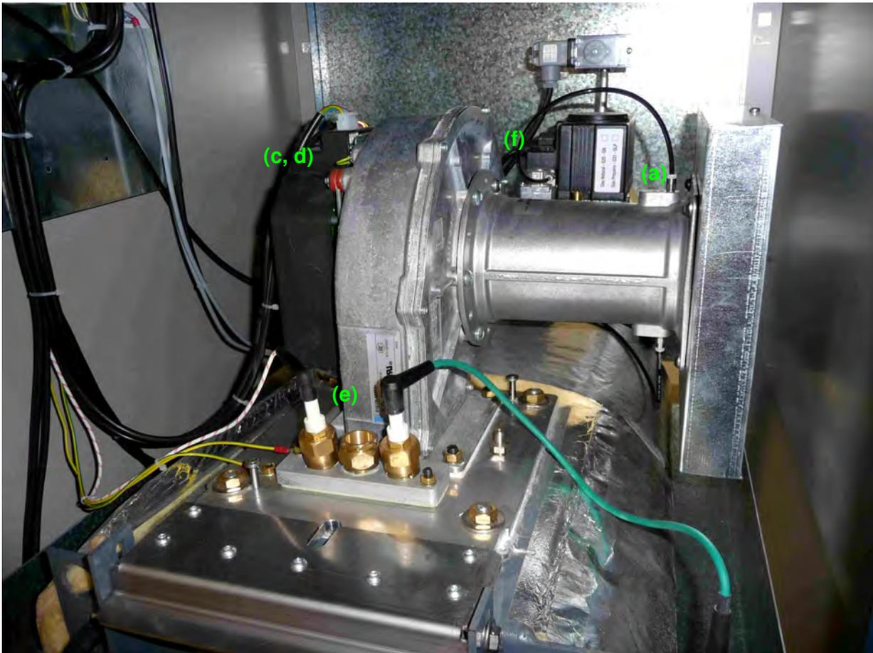
Отключите все электрические соединения и трубы под давлением:
